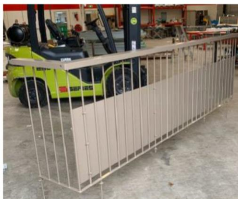
Foto: Intervam flats Mitros. Door architecten: hergebruik van bestaande balustrades. Gedemonteerd, schoongemaakt, rechtgezet, opnieuw gespoten en teruggeplaatst. In zijn totaliteit bleek dit niet duurder te zijn dan nieuw bestellen.
