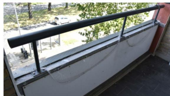
Foto: optopping borstwering in staal, complex 15 voorgevel.
